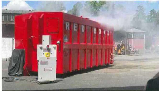
Während der Umsetzung der Batteriezellen wurde Lösch-aerosol über die Druckentlastungsöffnung auf dem Containerdach freigesetzt.
